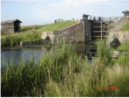
Das Papsluis im Schenkeldijk entlang der Bakkerskil in Werkendam, 2007 restauriert und wieder mit Kernholztüren ausgestattet.
