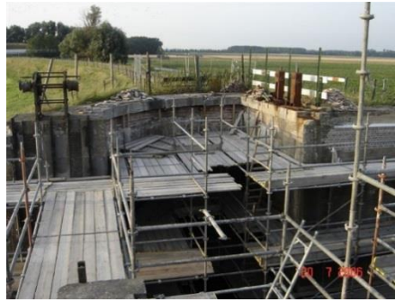
Das Papsluis im Schenkeldijk entlang der Bakkerskil in Werkendam, 2007 restauriert und wieder mit Kernholztüren ausgestattet.
